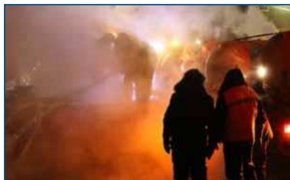
Устранение аварийной ситуации в системе теплоснабжения г. Мегиона
